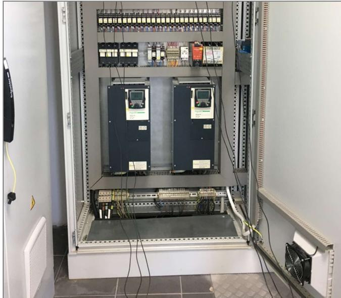
**Figura 2: Variadores de frequência para a regulação de caudal de bombas de recirculação na ETAR de Ribadumia.**
