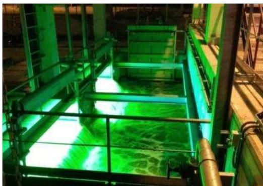
**Figura 23: Sistema de UV de baixa pressão, ETAR de Viveros da Villa**
