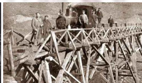
Funicular para o transporte do mineral dende Freixo ata a estación ferroviaria de Canaval, onde se cargaba en vagonetas con dirección ao porto de Rande, Vigo, e dende aí a Alemaña.
